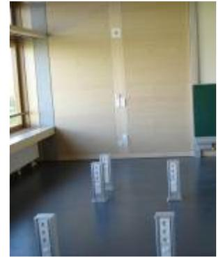
Alle Klassenzimmer sind mit Medienpaneelen als Bestandteil der Wandverkleidung ausgestattet, in die alle Bedienelemente der technischen Raumfunktionen sowie medientechnische Anschlüsse und der ELA- Lautsprecher integriert sind.
